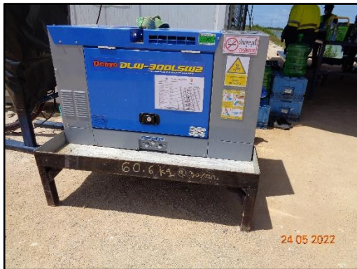
รูปที่ 2-17 ถาดรองน้ำมันเครื่องบริเวณเครื่องกำเนิดไฟฟ้าดีเซล
