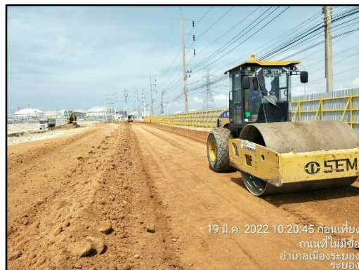
รูปที่ 2-1 การบดอัดดินให้เรียบรื้อก่อนเปิดพื้นที่ส่วนอื่น
