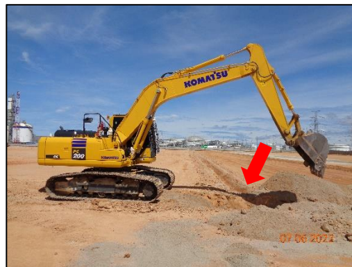
รูปที่ 2-26 กิจกรรมขุดวางระบายน้ำในพื้นที่โครงการ
