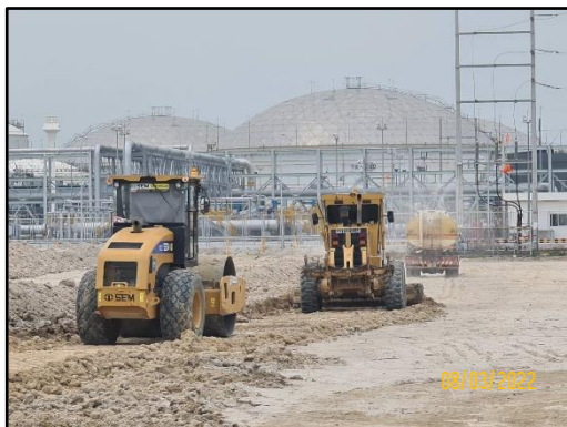
รูปที่ 2-1 การบดอัดดินให้เรียบรื้อก่อนเปิดพื้นที่ส่วนอื่น
