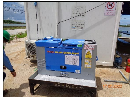
รูปที่ 2-17 ถาดรองน้ำมันเครื่องบริเวณเครื่องกำเนิดไฟฟ้าดีเซล
